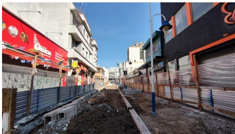
Figura 37 - Obras na Ruas Santa Catarina (2023)
