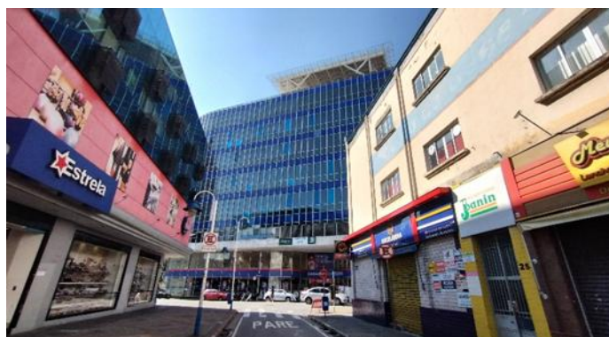
Figura 28 - Loja Casa Bahia vista da Rua Santa Catarina em novembro de 2023, antes das obras de requalificação urbana
