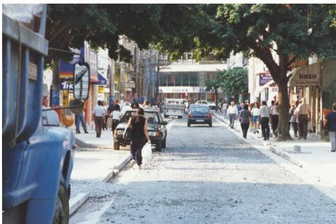
Figura 30 - Obras na Rua Santa Catarina em 1999
