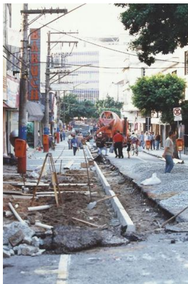
Figura 29 - Obras na Rua Santa Catarina em 1999
