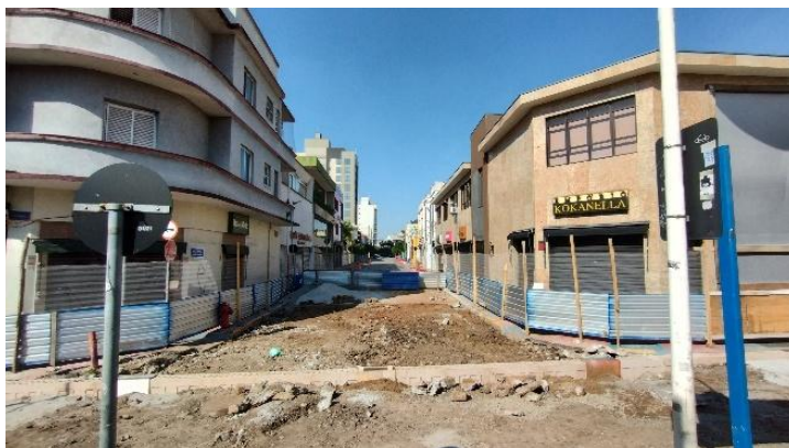
Figura 36 - Obras na Ruas Santa Catarina com Rua Pará (2023)
