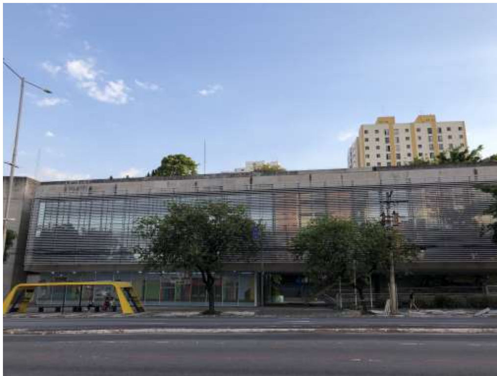
Figura 27 - Prédio da Secretaria de Educação de São Caetano do Sul e Biblioteca Municipal Paul Harris
