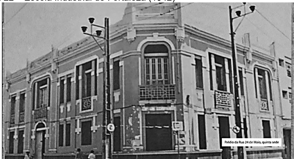
Figura 22 – Escola Industrial de Fortaleza (1942)
