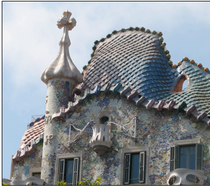
Fig. 112: Detalhe do telhado em formato das costas de um dragão
