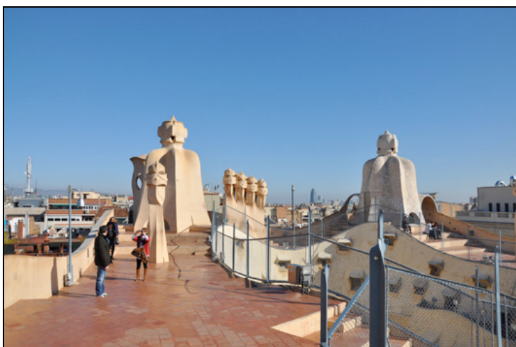
Fig. 87: La Azotea, área do telhado da Casa Milà onde se encontram as torres
