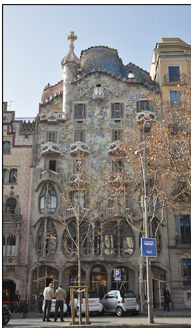
Fig. 110: Fachada da Casa Batlló
