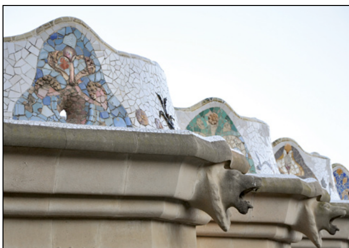
Fig. 121: Ornamentos de parte dos bancos feitos com pequenos pedaços de ladrilhos, o trencadís
