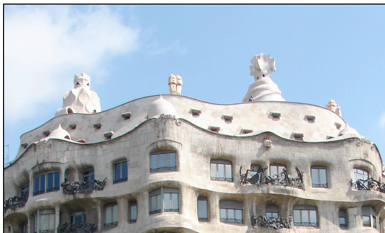
Fig. 103: Vista do telhado desde a Av. Passeig de Gràcia
