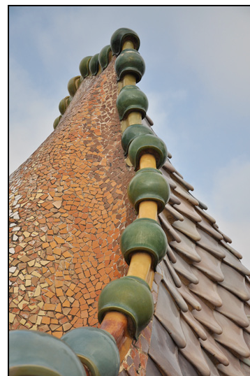
Fig. 114: Detalhe do telhado em formato das costas de um dragão
